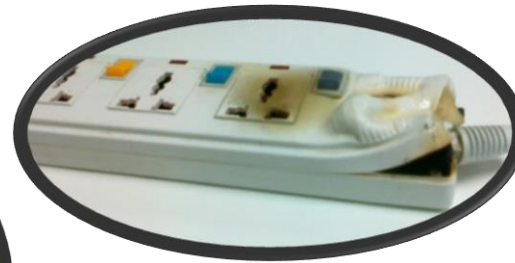
Kejadian kebakaran pada alat penyambungan elektrik di kantin Kementerian Pertahanan - 2010
